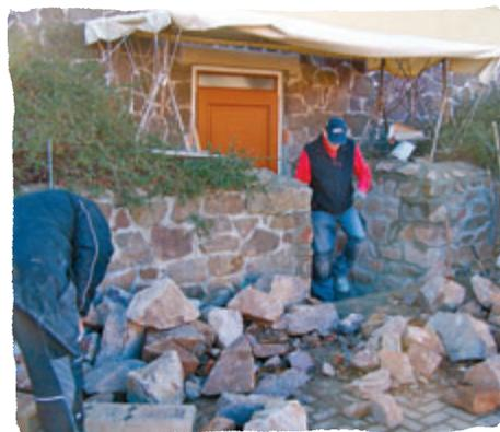
Das auf dem Gelände befindliche Nebengebäude (Florianstübchen) erhielt eine bauliche Überarbeitung. Die Räume waren wegen Durchfeuchtung kaum nutzbar. So wurden Mauerwerksteile trocken gelegt und teilweise ein neuer Putz aufgebracht. Das Gebäude konnte somit für die weitere Nutzung erhalten werden.
