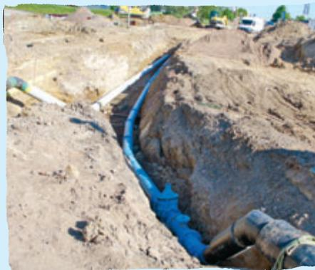
Im Zuge der Baumaßnahme „Ortsumgehung Kesselsdorf/B173“ musste die Versorgungsleitung auf einer Länge von 350 m neu bzw. umverlegt werden.
