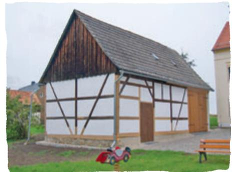
Das Gebäude erhielt eine neue Gründung, das stark in Mitleidenschaft gezogene Fachwerk wurde in großen Teilen erneuert und ergänzt. Danach erfolgte denkmalgerecht der Einbau einer Lehmausfachung. Die Dachfläche wurde repariert. Auf der Hofseite wurden zwei neue Tore eingebaut.
