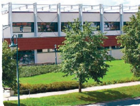
Im Jahr des 10-jährigen Bestehens der Dreifeldhalle machte sich eine Überarbeitung der Fassade erforderlich. Die gesamte Putzfassade erhielt einen neuen Anstrich, ebenso die massiven Stahlträger. Insbesondere für die Stahlträger muss der Korrosionsschutz gewährleistet werden, da diese das Tragwerk der Halle bilden.
