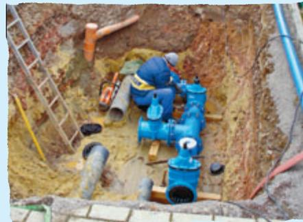
Die Kreisstraße von Kesselsdorf nach Oberhermsdorf soll im 2. Bauabschnitt 2012 im grundhaften Ausbau fertig gestellt werden. Dazu war es erforderlich, die vorhandene Trinkwasserversorgungsleitung auf einer Länge von ca. 250 m auszuwechseln.
