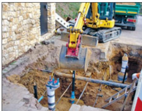
Die rohrtechnische Sanierung der Druckerhöhungsstation (DEST) in Blankenstein durch die Firma Krause & Co. Neukirchen-Adorf war auf Grund des Alters der Technik dringend geboten. Im Januar 2015 soll dann die Druckerhöhungsstation an das Netz angeschlossen werden.
