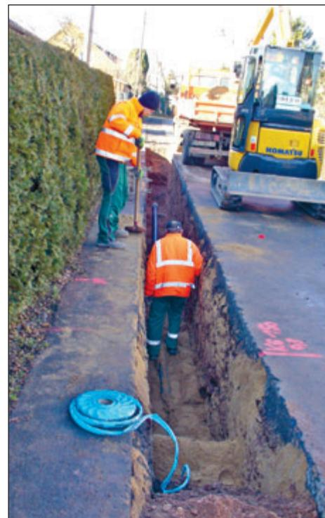
Mit der Neuverlegung der Trinkwasserleitung Gartenstraße in Kleinopitz wurde neben der Erschließung von Grundstücken auch der Ringchluss für das Leitungssystem hergestellt.
