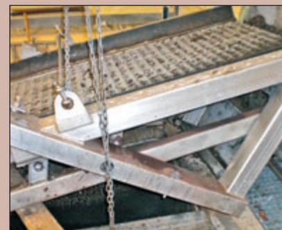
Eine Kugeldrehverbindung am Belebungsbecken 2 wurde erneuert. Der Doppelrostfeinrechen wurde repariert und Verschleißteile ausgetauscht.
