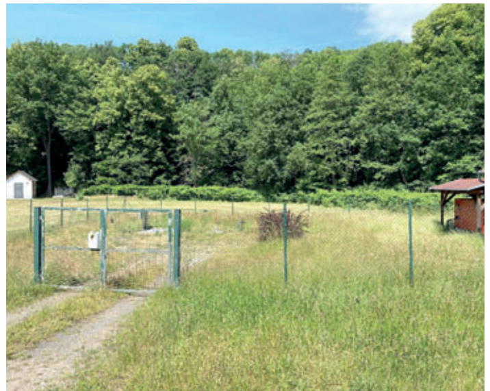
Blick auf das Pumpwerk Freiberger Straße – Mohorn
