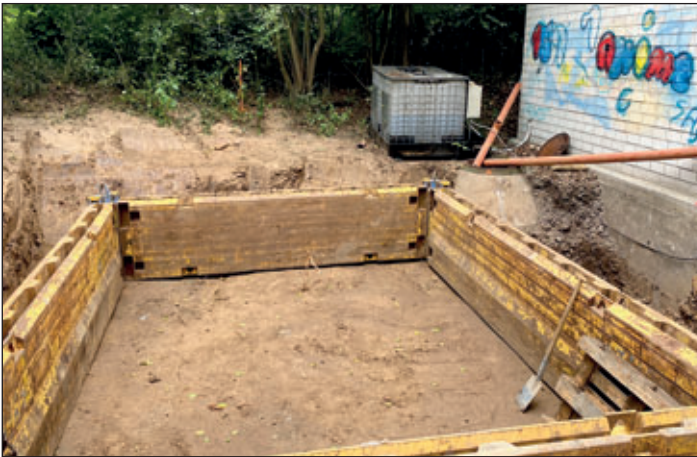
Beginn des Aushubs der Baugrube (DN 2000)
