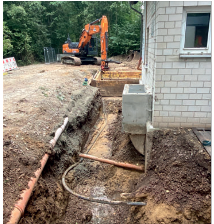
Beginn des Aushubs zur Verlegung der Druckleitung
