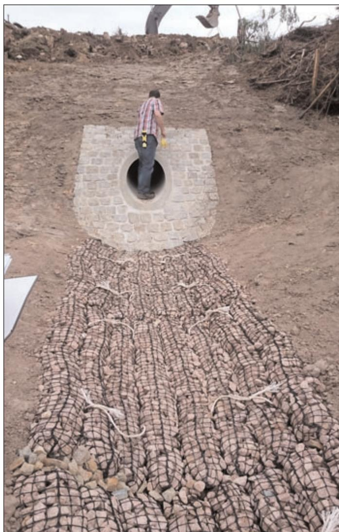
Kleinopitz – Auslaufbereich mit Böschungstück und Steinmatratten
