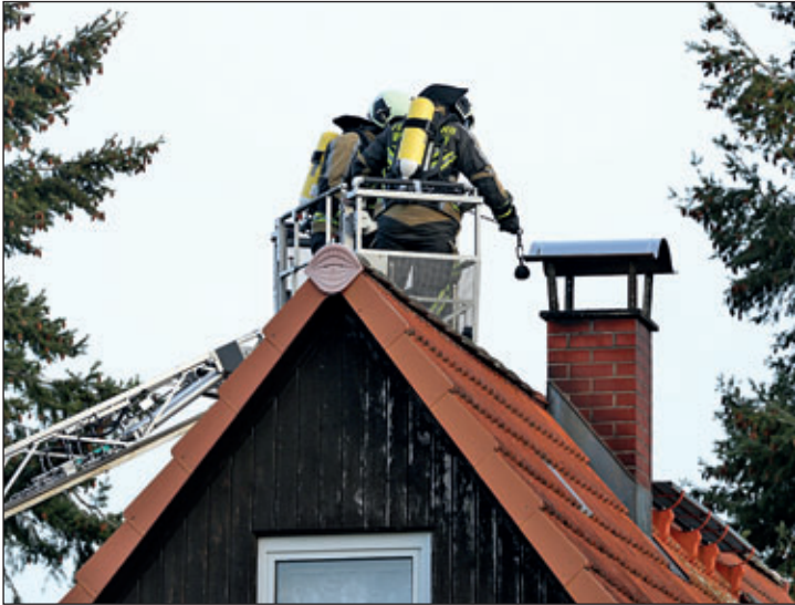
Das Essenkehrgerät wird in den Schornstein eingelassen, um den brennenden Ruß zu lösen.
