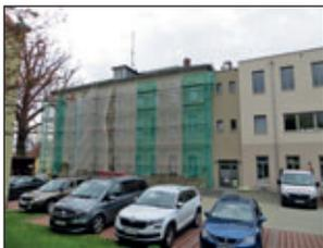
forderliche Gerüst gestellt und mit dem Abbruch des alten Putzes begonnen. Im Anschluss folgen die Natursteinarbeiten zur Reparatur und Aufarbeitung der Sandsteingewände. Im Dachgeschoss wurden bereits kleinere Umbauarbeiten zur Schaffung eines weiteren Arbeitsplatzes durchgeführt. Nun haben der Bodenleger und der Maler ihre Arbeiten aufgenommen.
