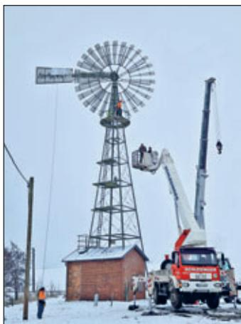
und ein LKW mit Ladearm für den Transport der einzelnen Teile. Der Bagger des Bauhofes wurde ebenfalls zur Unterstützung benötigt. In den Wochen vor dem Montagetermin waren alle Teile schon mal versuchsweise zusammengesteckt oder geschraubt worden, entweder auf dem Betriebsgelände der Firma Wennrich in Grumbach oder an der Lagerhalle des Bauhofes in Wilsdruff. Die neu angefertigten oder überarbeiteten Teile mussten ja zusammenpassen, dass gelang nicht immer auf Anhieb. Und eine probe-
