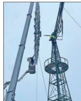
Das Windrad wurde vorerst aus dem Wind gedreht, wird sich aber trotzdem bei etwas stärkerem Wind langsam drehen. Es fehlt noch die Montage einiger Kleinteile für die Windnachführung und Regelung, dafür wird sich noch ein geeigneter Tag finden.
