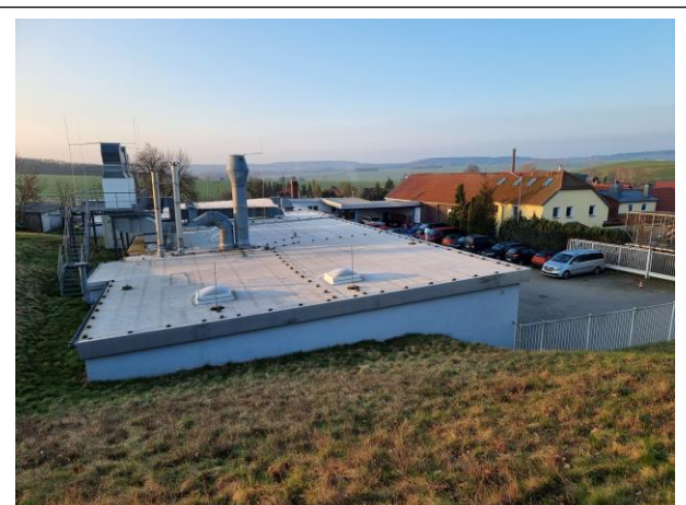
Blick von Nord nach Süd auf das Bestandsgebäude an der Grenze zum Hang
