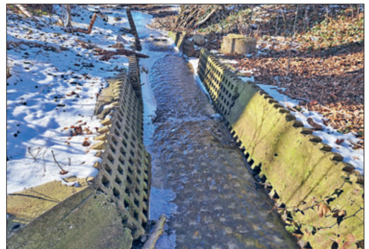
Ein mit Rasengittersteinen verbautes Gewässer. Die Platten sind instabil und im Hintergrund kann man sehen, wie sie bereits ins Gewässer fallen. Zurück bleibt ein ungeschütztes Ufer.
